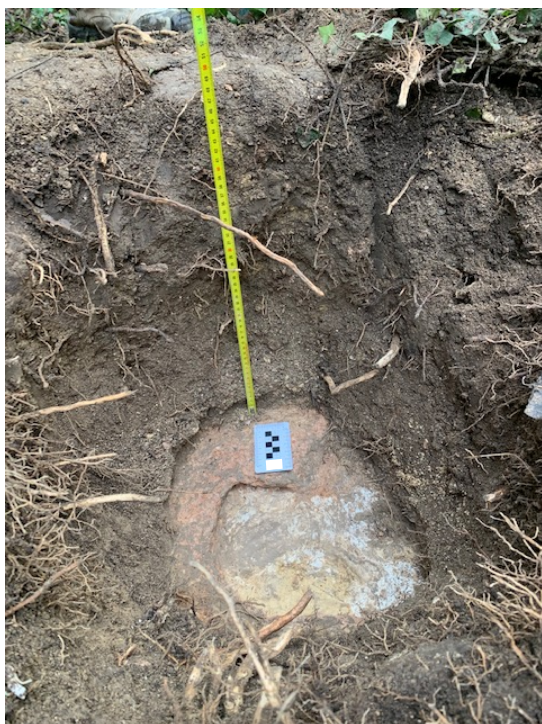
Figure 17: Aperçu de la hauteur de la terre végétale en clé de coupole
