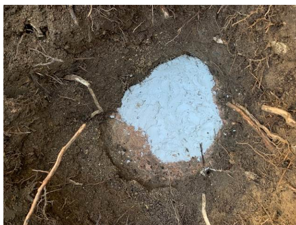
Figure 20 : Rebouchage du sondage avec un mortier hydrofuge de masse
